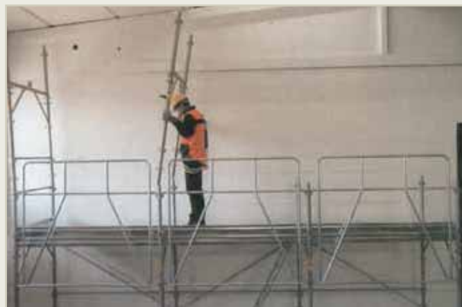
2 Montaggio del II telaio SICURTOP l'operatore dispone di una protezione regolamentare
