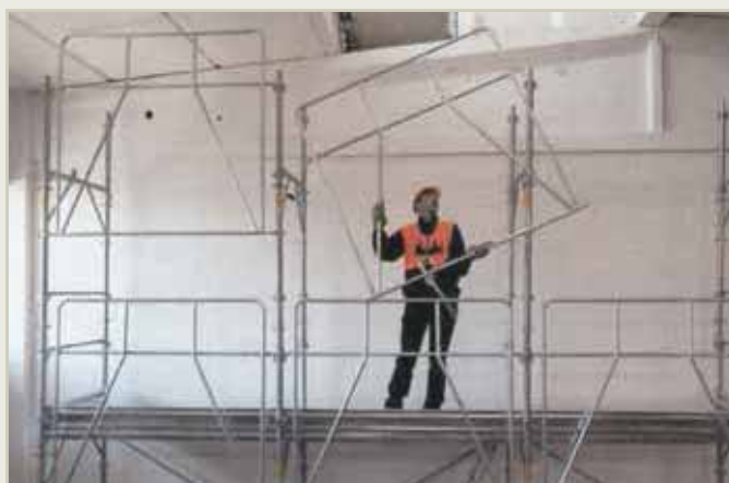
3 Montaggio della sponda SICURTOP avente funzione di controventatura di facciata
