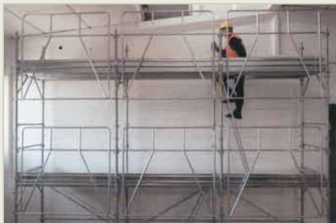
5 Completato in piena sicurezza il montaggio del II piano di lavoro l'operatore può salire sull'impalcato superiore per continuare la sua attività.
