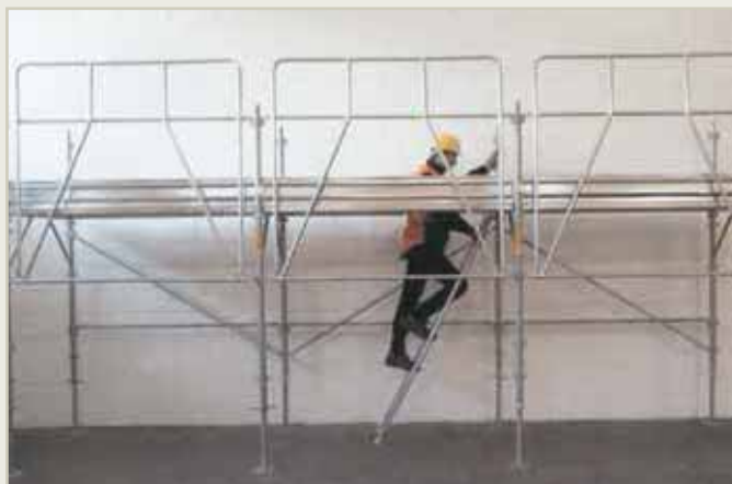
1 Tracciamento e livellamento del primo piano di ponteggio
