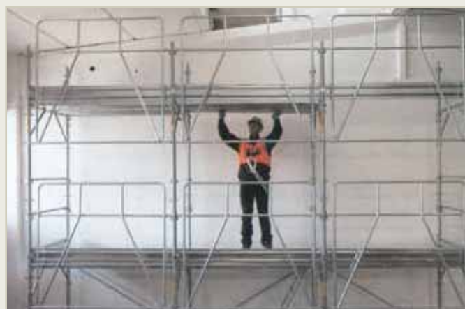
4 Montaggio delle tavole metalliche strutturali EURO 1 aventi funzione di controventatura orizzontale e dei fermapiedi di facciata
